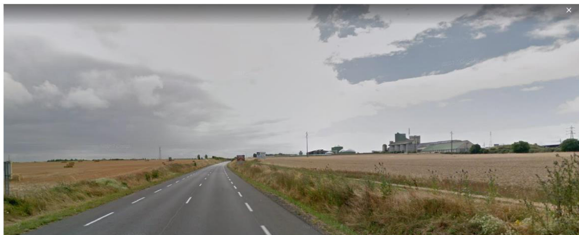
Vue sur le secteur d'étude entre la RD 938 et la voie ferrée depuis la RD938
